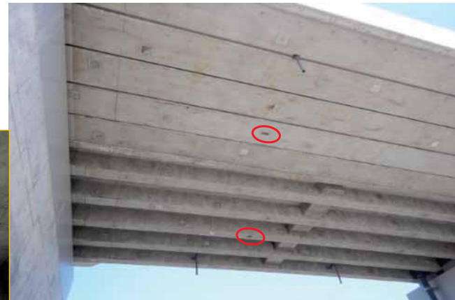
＜剥離・鉄筋露出の模擬供試体＞
