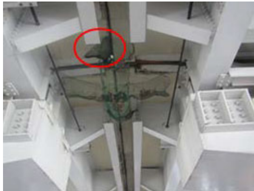
補修補強材の状態
