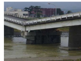
橋脚の沈下
