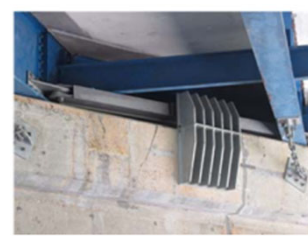
主桁端部(鋼橋)
