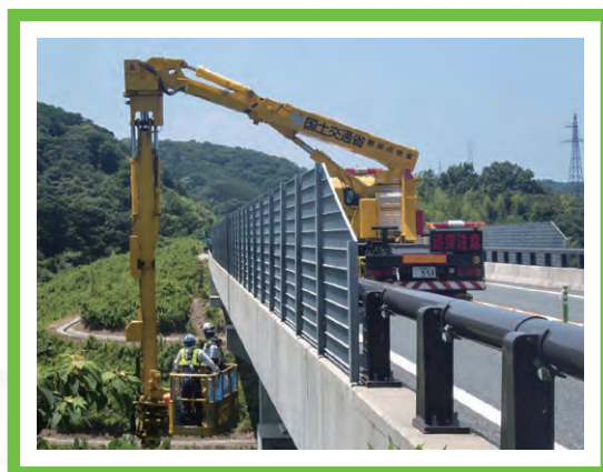
橋梁点検車を利用した診断
