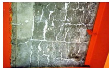
内部の鉄筋腐食が疑われる例
