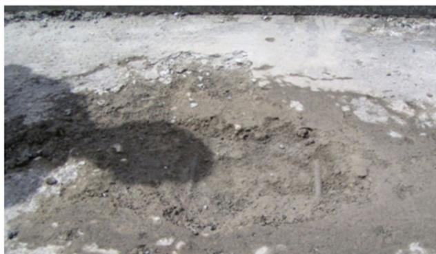
床版上面の土砂化
