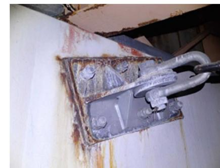
アンカーボルトの腐食
