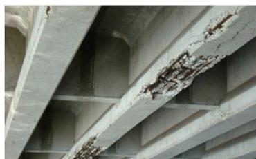
鉄筋腐食による剥離
