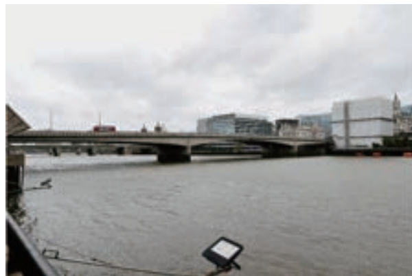
写真-11 ロンドン橋
