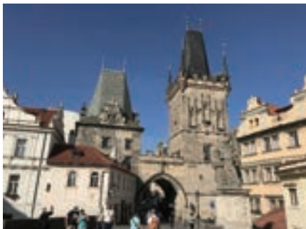
写真-4・5 カレル橋・橋塔
