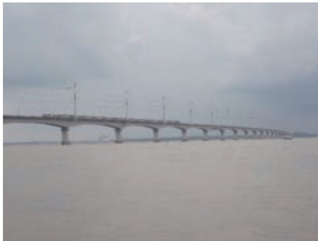
写真-10 供用中のジャムナ多目的橋 （多径間連続PCゲルバー箱桁橋）
