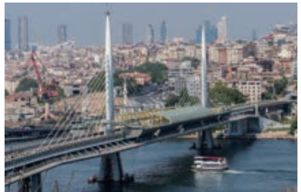
写真-12・13 金角湾メトロ橋（駅上から撮影）
