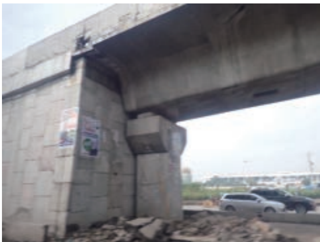
写真-9 橋梁端部（橋脚と土留め壁分離構造）
