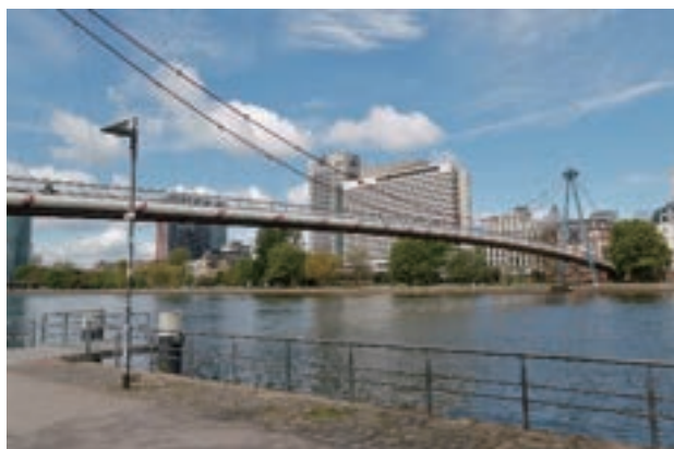
写真-20 ホルバイン歩道橋
