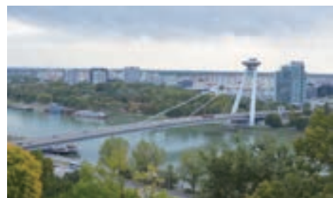
写真-8 新ドナウ川橋
