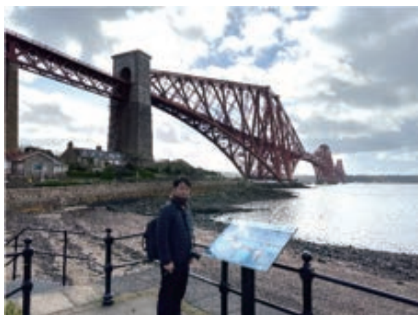
写真-13 フォース鉄道橋（北側より）
