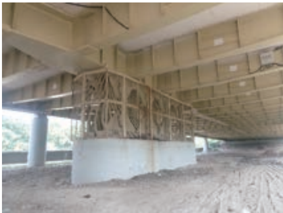
写真-8 アンカー基部（床組み・支承を介し基礎に接続）
