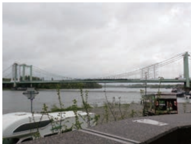
写真－16 ローデンキルヒェン橋
