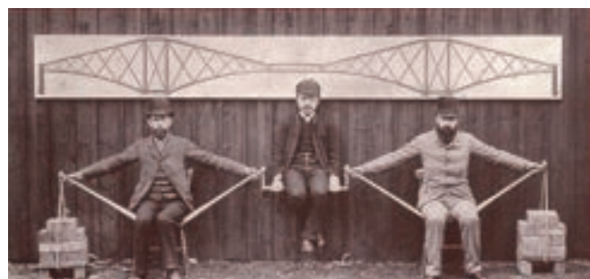
写真-14 カンチレバーの原理をモデル化する3人 中央に映っているのが日本人技師渡邊嘉一氏 (公式HP https://www.theforthbridges.org/ より)
