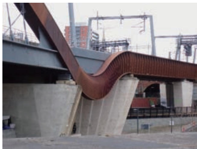
写真－9 River Irwell Bridge（端部近影）
