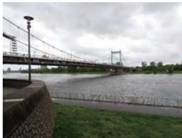
写真－17 ミュールハイム橋
