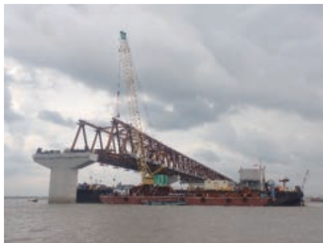
写真-15 架設状況
