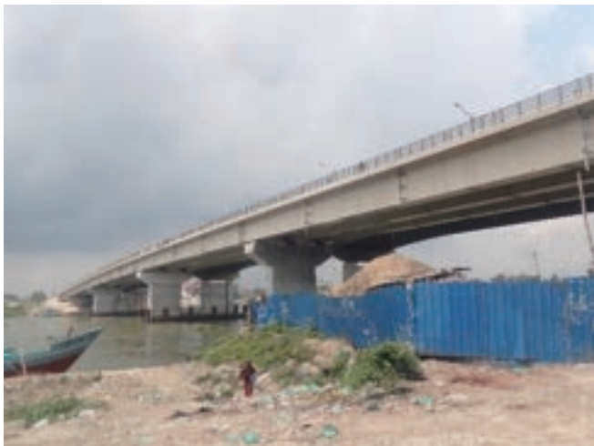
写真－17 第2カチプール橋
