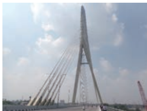
写真-5 Signature Bridge主塔（手前が陸側）
