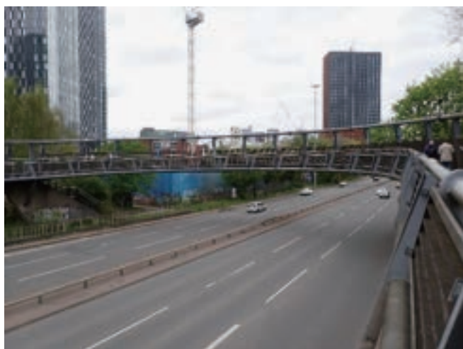
写真－7 Mancunian Way Footbridge（側面）
