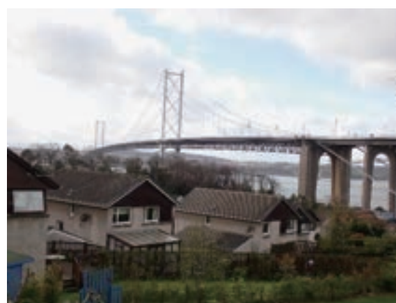
写真-15 フォース道路橋
