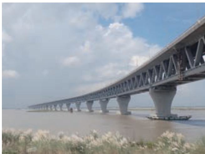
写真-20 パドマ多目的橋：鋼トラス橋（2層式）
