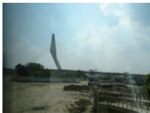
写真-6 Signature Bridge主塔（右が河川側）
