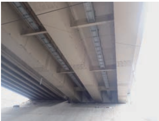
写真－18 3主桁、桁間に検査路完備
