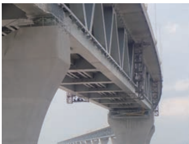
写真-24 足場上での作業
