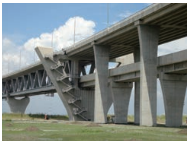
写真-22 掛け違い部の橋脚
