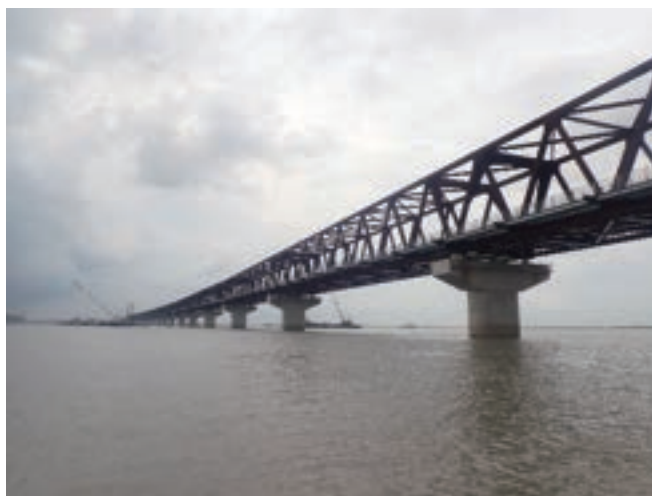
写真-11 ジャムナ鉄道専用橋（架設中）
