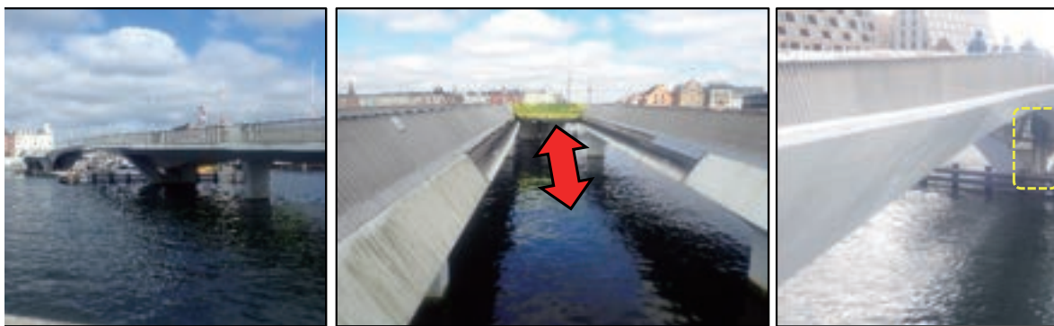
図-6 インダーハウンスブローエン橋
