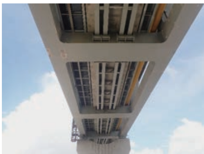
写真-21 桁下状況（下路部は軌道）
