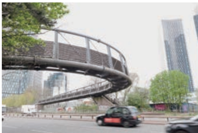
写真－6 Mancunian Way Footbridge（下面）
