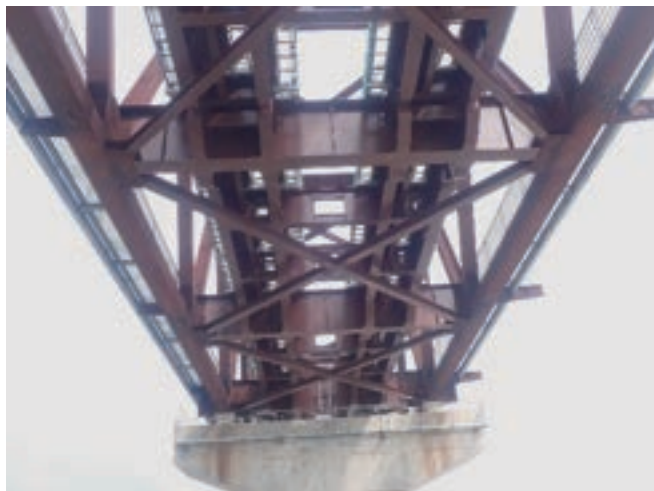
写真-12 桁下状況（床組みはC5塗装系）
