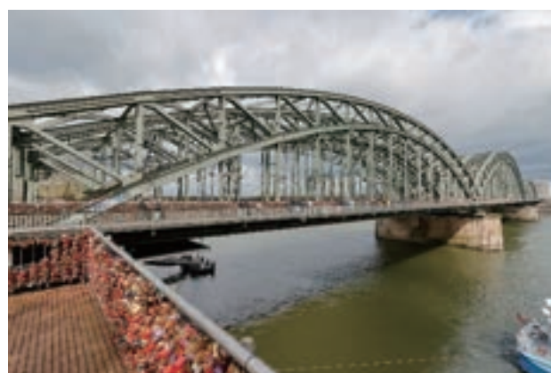
写真－18 ホーエンツォレルン橋
