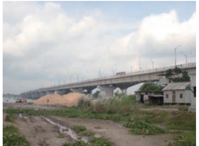
写真－19 第2ゴムティ橋
