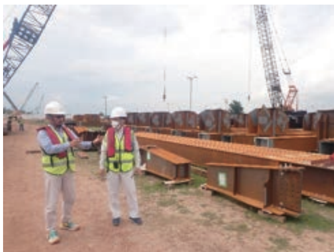
写真-14 仮置き場（塗装ヤードを併設する）
