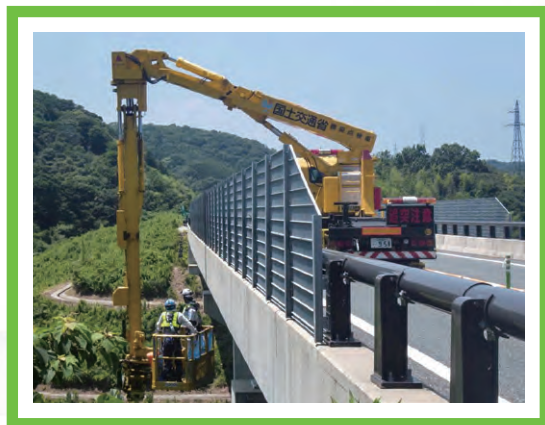
橋梁点検車を利用した診断
