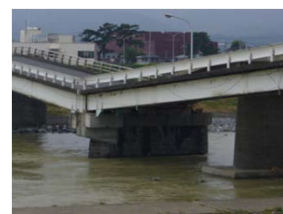
橋脚の沈下
