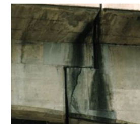
▲ゲルバー部の狭隘部
