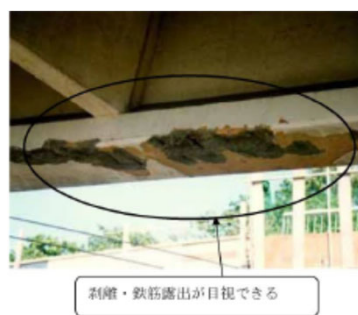
断面修復部の剥離・鉄筋露出
