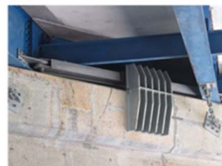
▲鋼橋桁端の狭隘部
