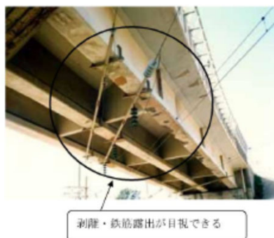
断面修復部の剥離・鉄筋露出
