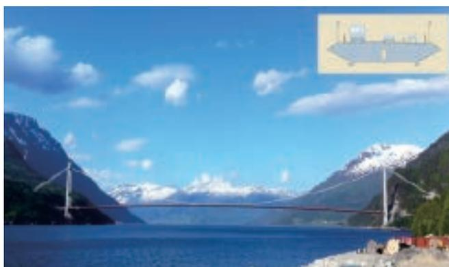
写真-7 中央支間長1310mの吊橋Hardanger橋
