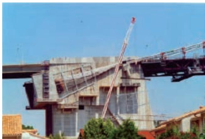
写真-6 増設したエアタイトのアンカレイジチャンバー
