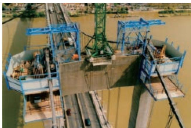
写真-5 ケーブルを新設するための塔頂の拡幅
