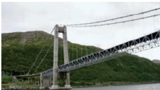
写真-5 トラス補剛桁を用いた初期の吊橋Sotra橋
