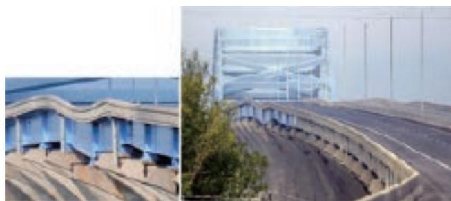
写真-3 沈下が発生した道路橋
