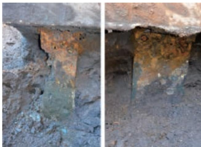
写真-4 基礎杭の損傷状況
