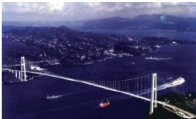
写真-6 箱桁を最初に用いた吊橋Askøy橋
