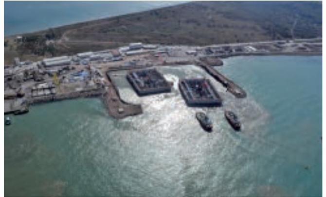
写真-6 ドライドックで製作した主塔基礎の引き出し状況
