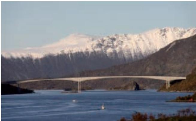
写真-2 中央支間長世界一のPC箱桁橋
