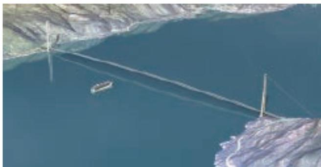
写真-10 中央支間長3700mの吊橋案
