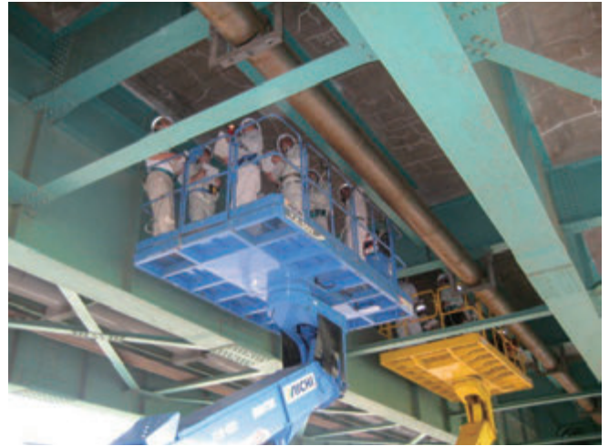
写真-2 近接目視点検の現地実習
