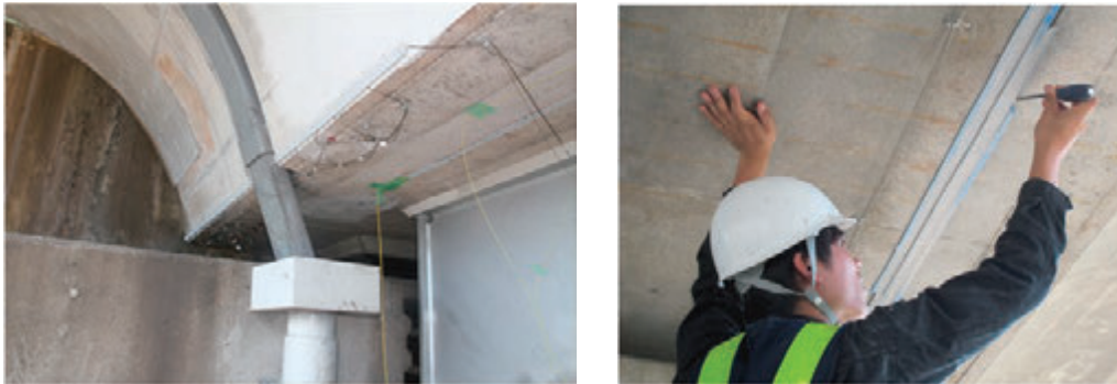
図9 光ファイバセンサ貼付けの様子
