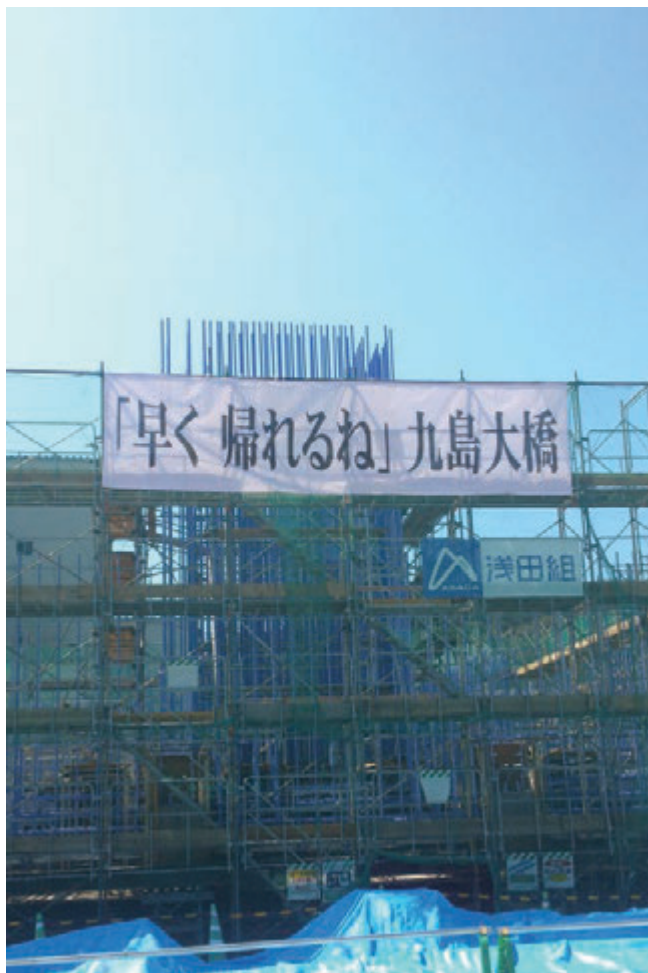
写真-4 下部工橋脚の製作現場
