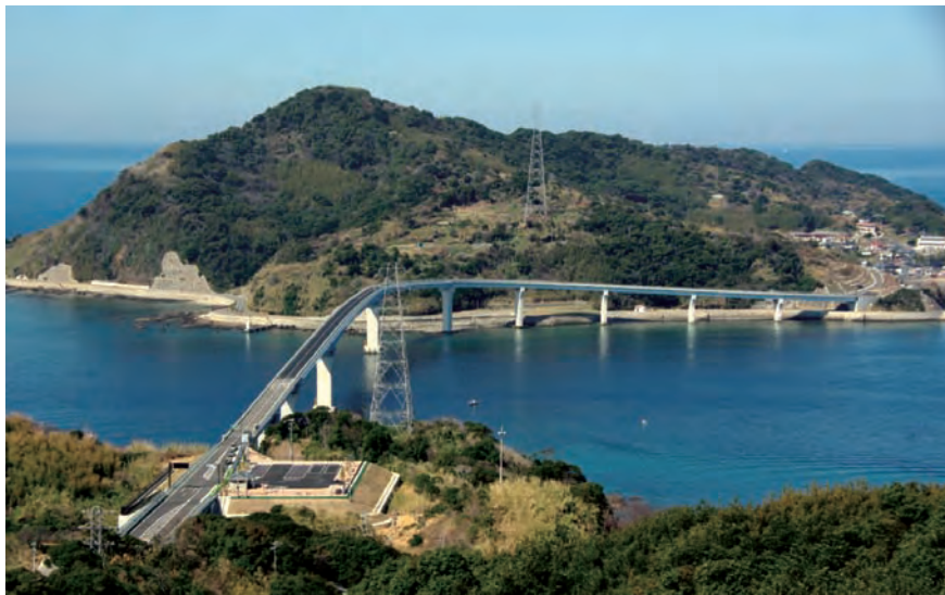
写真一7 完成した伊王島大橋の全景
