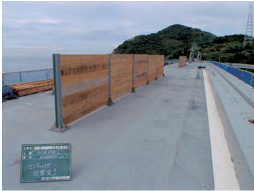
写真一5 センターバリア設置状況
