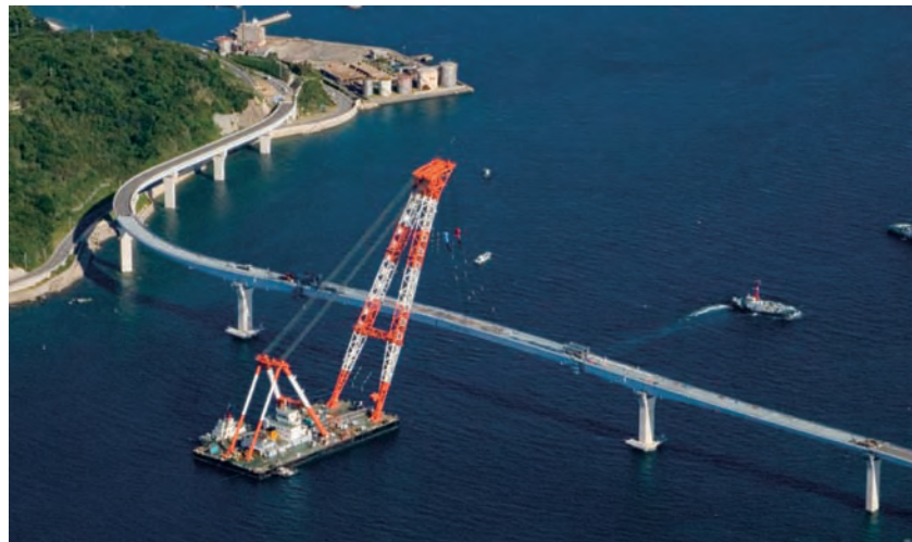
写真-1 架設状況
