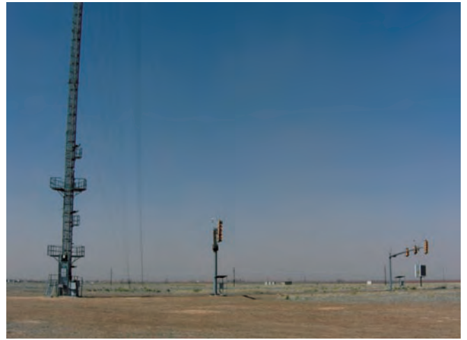
写真-3 風況 計測タワー
