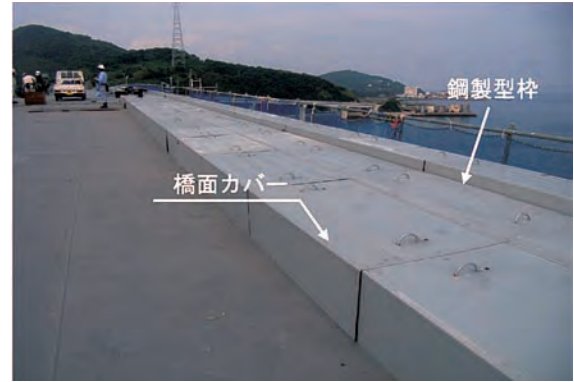
写真一6 橋面カバー設置状況
