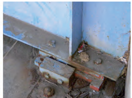
写真-6 上沓ストッパーの変形・破断、遊間異常 (国道45号 面瀬川橋)
