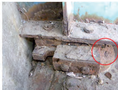
写真-6 上沓ストッパーの変形・破断、遊間異常 (国道45号 面瀬川橋)
