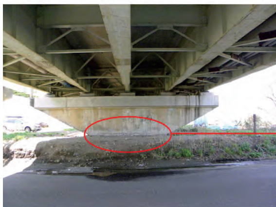
写真-4 RC橋脚のひびわれ・コンクリート剥離・鉄筋はらみ出し (国道4号 名取大橋)
