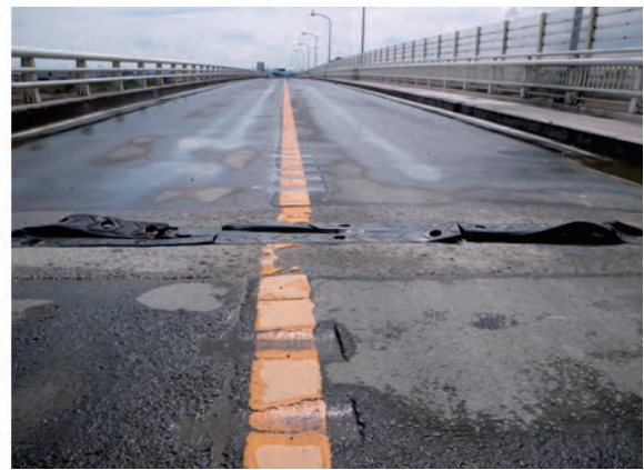
写真-3 ラーメン橋中央ヒンジ部の変位 (主要地方道塩釜巨理線 関上大橋)
