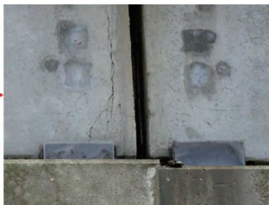
写真-1 主桁端部（支点部）のひびわれ（主要地方道塩釜巨理線 関上大橋）
