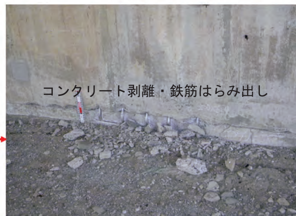
写真-4 RC橋脚のひびわれ・コンクリート剥離・鉄筋はらみ出し (国道4号 名取大橋)
