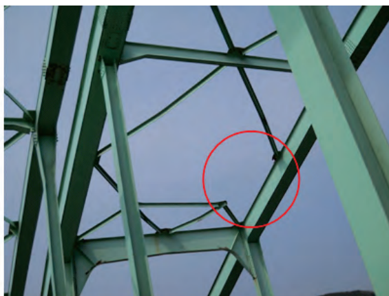
写真-2 上横構の座屈・破断（国道45号 天王橋）
