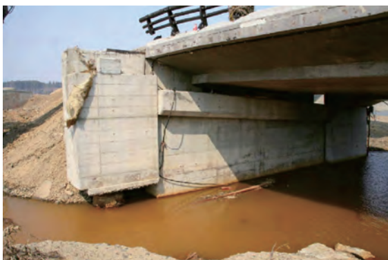
写真-25 基礎の洗掘 (国道45号 外尾川橋)
