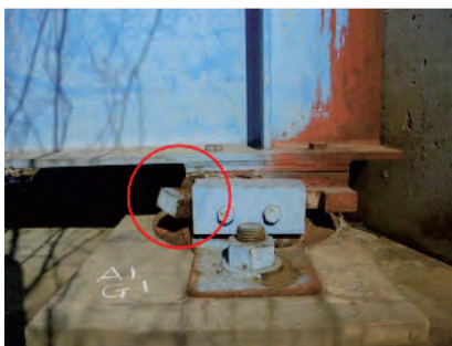
写真-6 上沓ストッパーの変形・破断、遊間異常 (国道45号 面瀬川橋)
