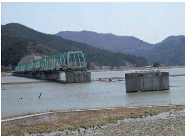
写真－17 主構トラスの流出（国道398号 新北上大橋）
