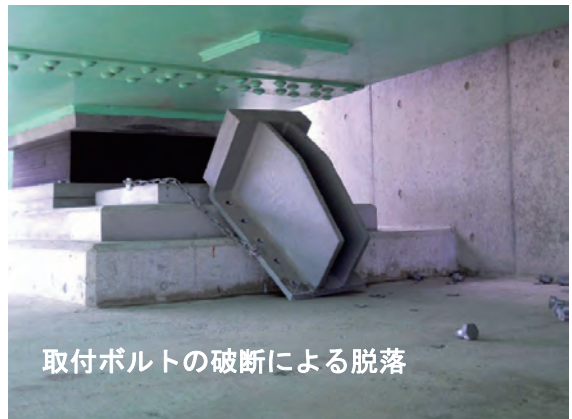
写真-10 ジョイントプロテクターの脱落 (国道45号 (三陸自動車道) 新天王橋)
