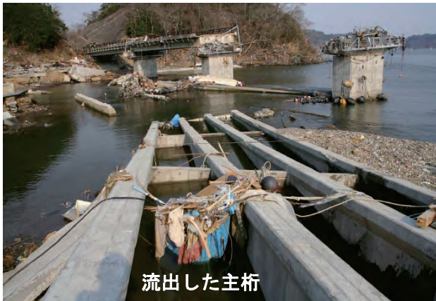
写真－15 主桁（PCT桁）の流出（国道45号 歌津大橋）
