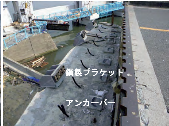
写真－15 主桁（PCT桁）の流出（国道45号 歌津大橋）
