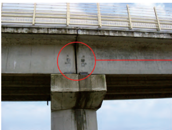
写真-1 主桁端部（支点部）のひびわれ（主要地方道塩釜巨理線 関上大橋）
