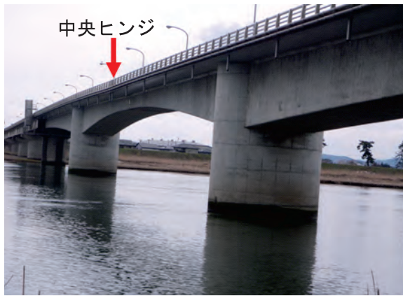
写真-3 ラーメン橋中央ヒンジ部の変位 (主要地方道塩釜巨理線 関上大橋)
