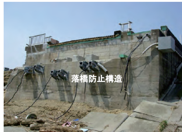
写真－17 主構トラスの流出（国道398号 新北上大橋）
