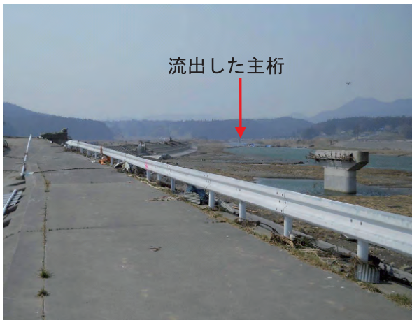
写真－16 主桁（鋼鈹桁）の流出（国道45号 小泉大橋）
