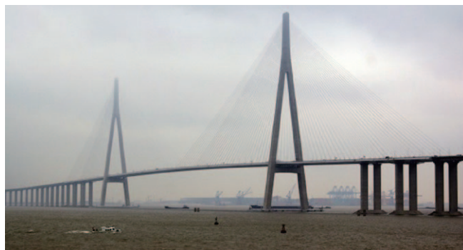
写真-4 Sutong Bridge（斜張橋、中央支間長1,088m、揚子江）
