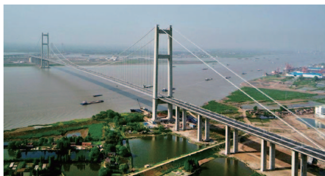
写真-3 Runyang Bridge（吊橋、中央支間長1,490m、揚子江）
