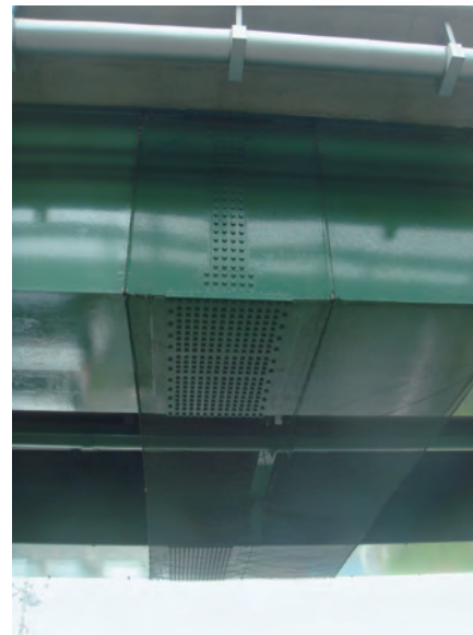
写真-6 ボルト脱落の防止策
