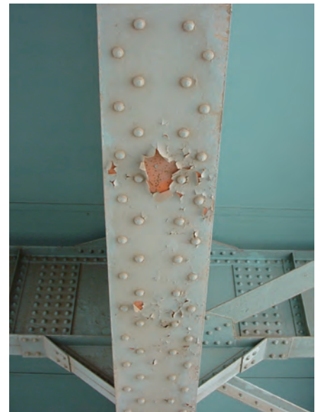
写真-8 塗膜の損傷
