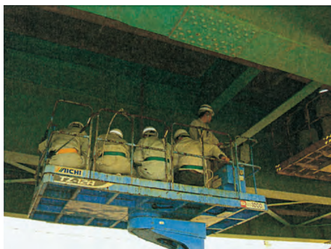
写真-2 現地点検研修 (2)
