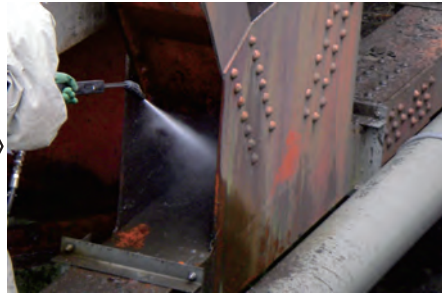
写真-6 トラス部材格点部の洗浄
