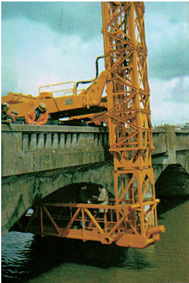
写真-1 点検車による点検の状況
