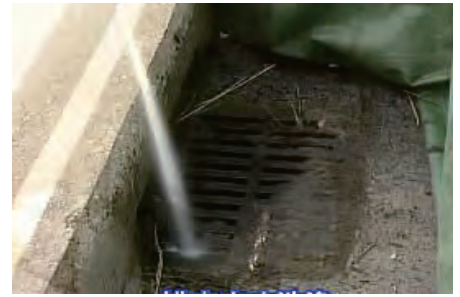
写真-5 排水ますの洗浄
