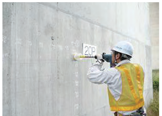
写真-4 ドリルによる削孔粉の採取
