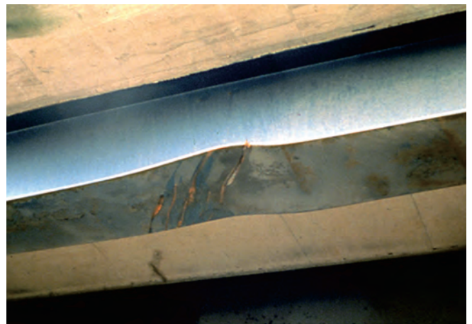
写真-2 鋼桁への衝突痕
