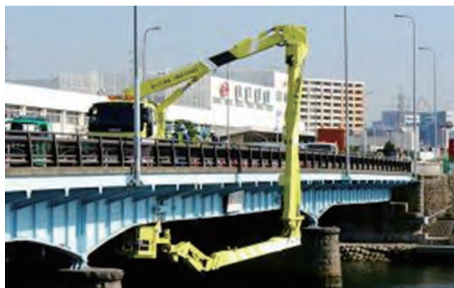
写真-1 橋梁点検車による点検
