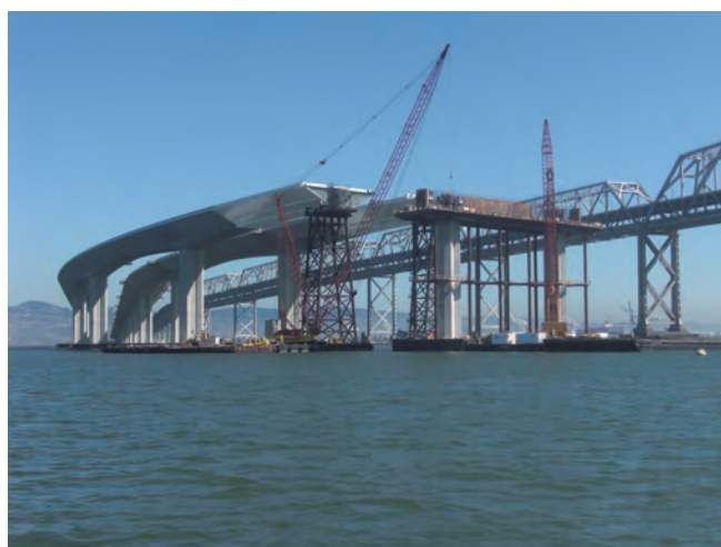
写真-3 オークランドベイブリッジ（東橋）の架け替え工事
