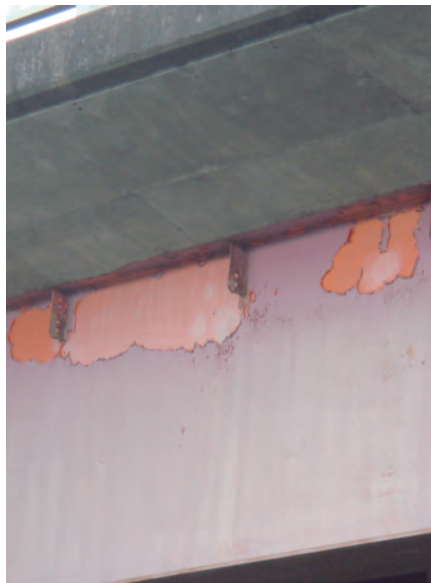
写真-8 塗膜の損傷
