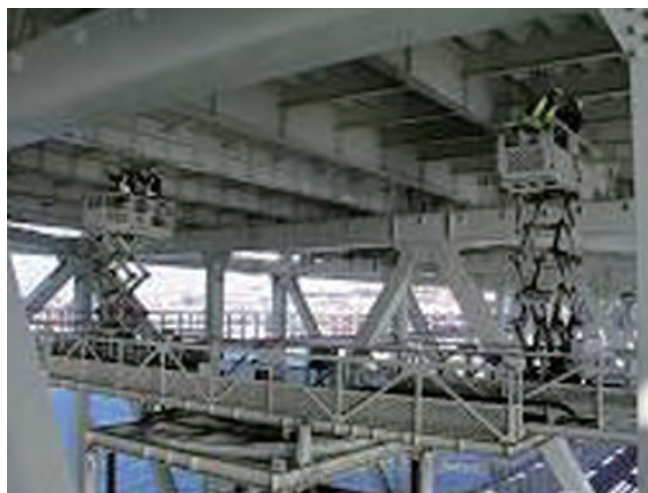
写真-1 桁内面作業車による近接目視・触指
