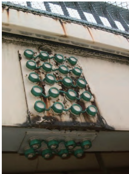
写真-6 ボルト脱落の防止策
