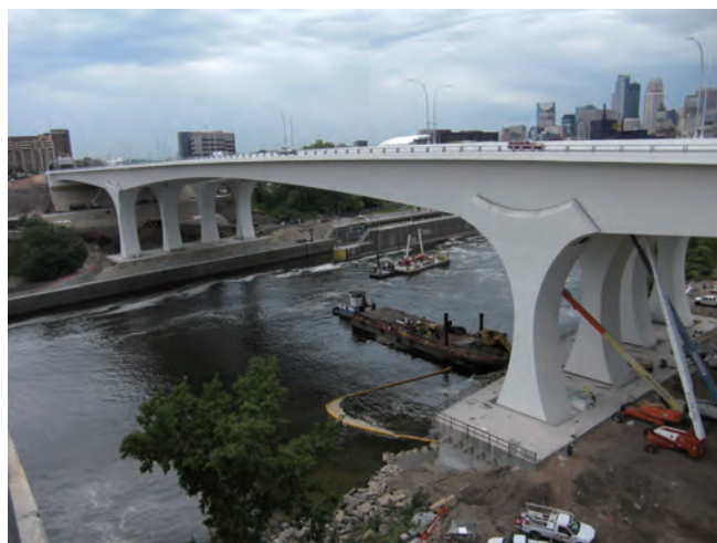
写真-2 再建されたI-35Wの新橋 （旧橋の崩壊から1年余りの2008年9月18日に供用された）
