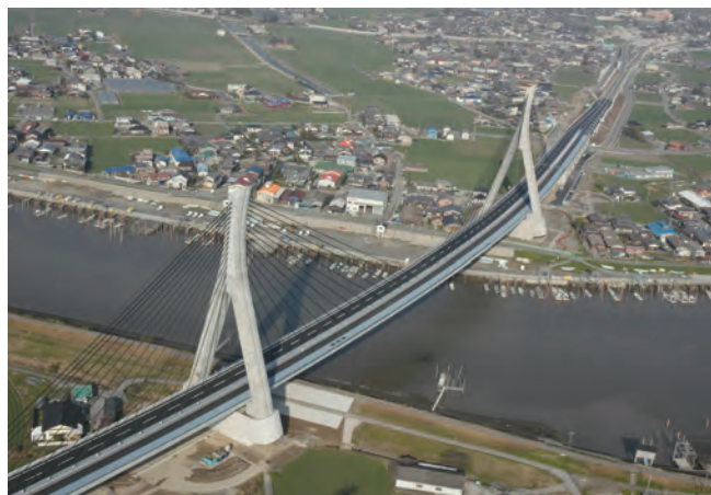
写真一 矢部川大橋全景
