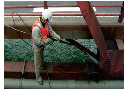
写真-5 排水ますの洗浄
