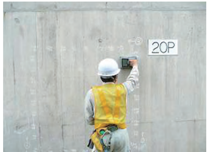
写真-3 RCレーダーによる鉄筋かぶり調査
