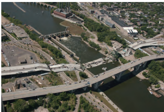
写真一1及び写真一2 I-35W 崩落状況 (出典：ミネソタ州交通局Mn/DOT HPより)
