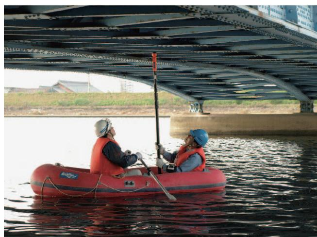
例えば、写真のように橋梁裏面をボート上から点検する場合、脚立・はしごは使えないため遠望目視とならざるを得ません、本点検器を使用すれば橋梁に近接して観察出来るとともに、その画像をデータとして記録しておけば、後に様々な解析や編集が可能となります。
