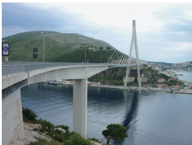
写真-3 ドゥブロブニク斜張橋(最大支間長304m)
