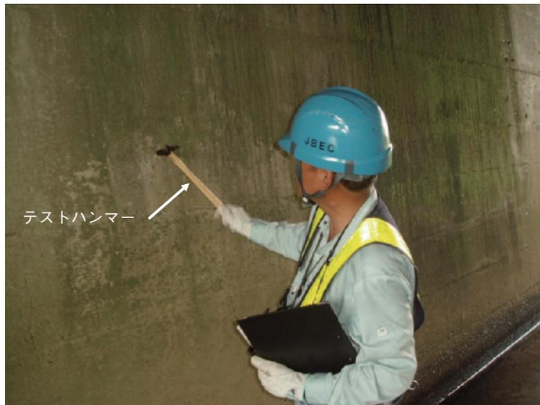
写真-2 テストハンマーによるコンクリートの「うき」の調査
