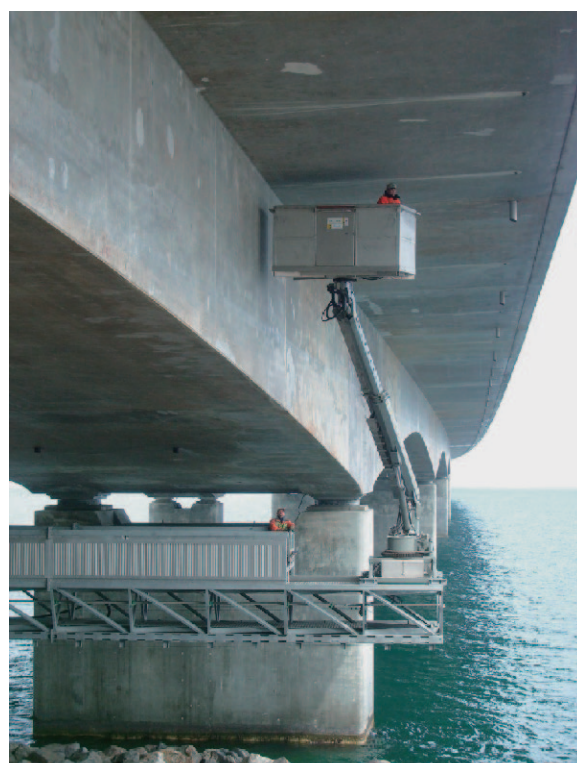
写真-5 West Bridge外面作業車
