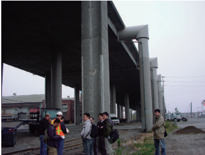
写真-3 地震被害復旧後の高架橋 (Alaskan Viaduct)
