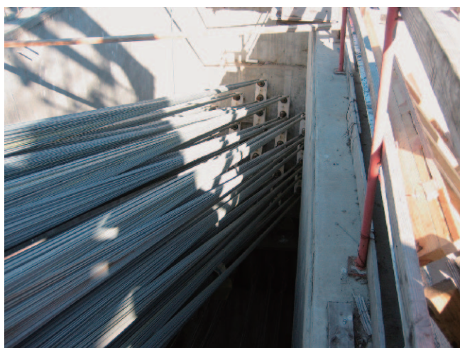
写真-2 ケーブル定着部
