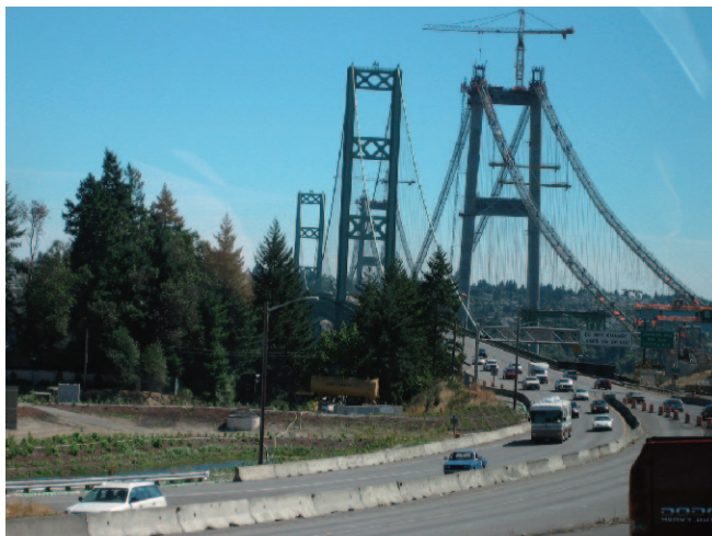
写真-1 左側が現橋、右側が新橋 (Gig Harbor側より)
