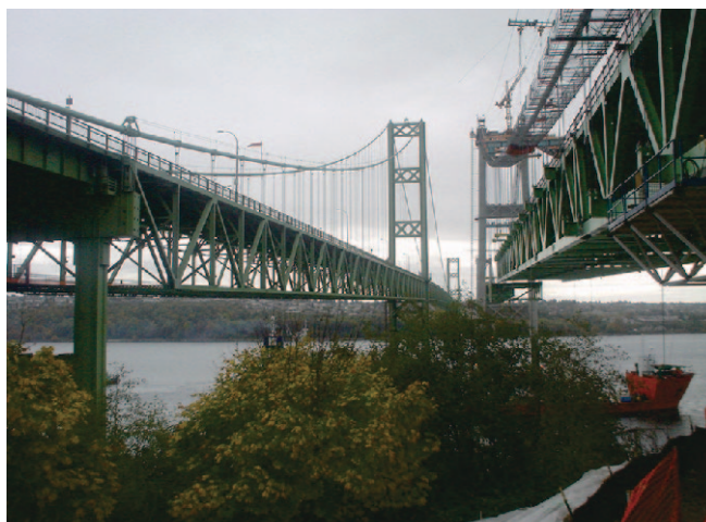
写真－2 現タコマ橋（左）と建設中の新タコマ橋
