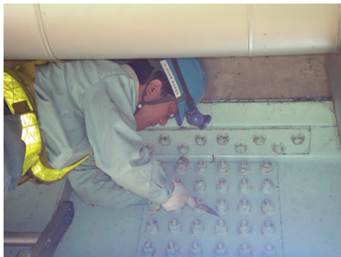
写真-4 ボルトが緩んでいないか、ハンマーで叩いて調べます。
