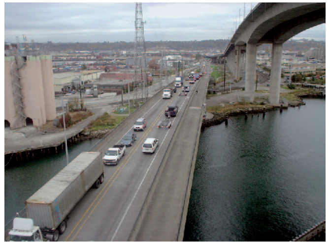
左：クレーン線が通過中 右：閉合後の車両通行
