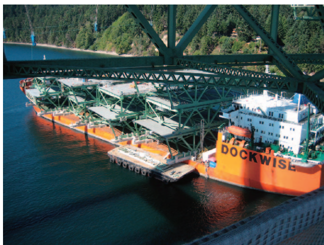
写真-3 補剛桁の運搬船
