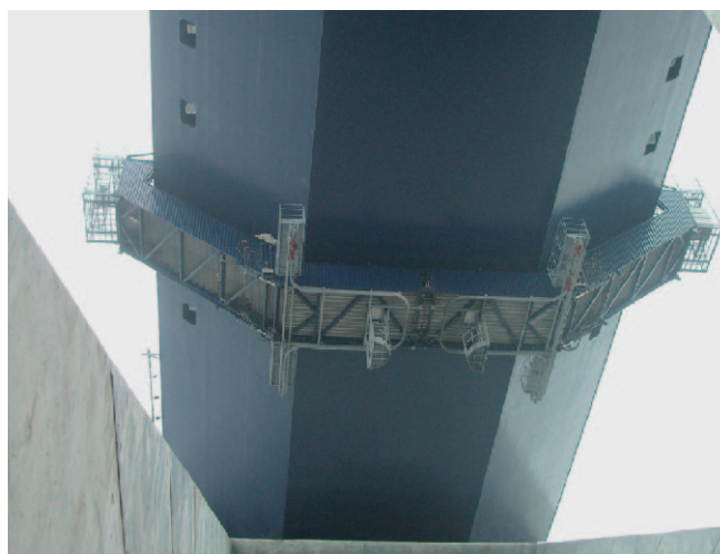
写真-4 East Bridge主桁外面作業車
