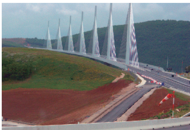
写真-9 路面上より
