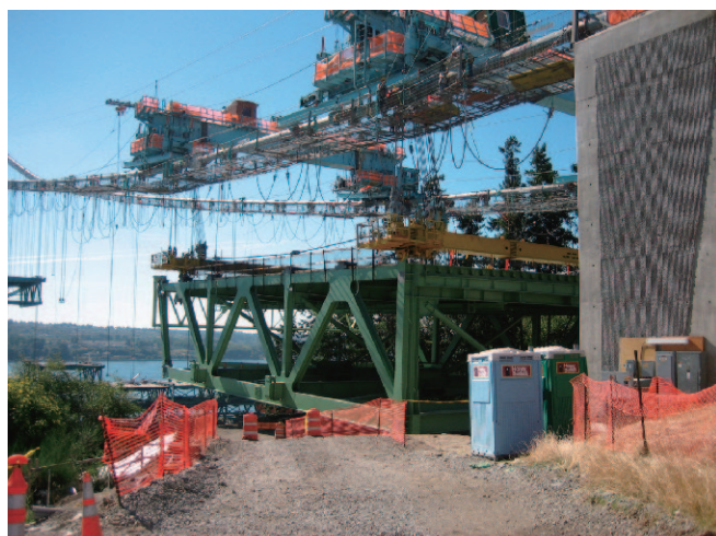
写真-4 側径間補剛桁架設状況
