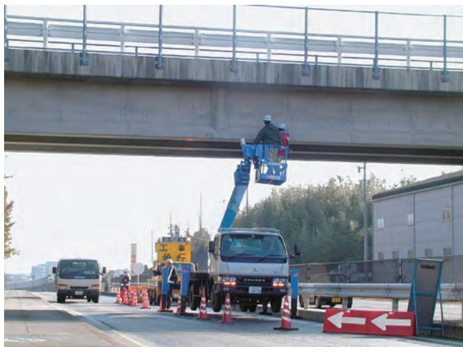
写真-3 高所作業車による近接目視点検
