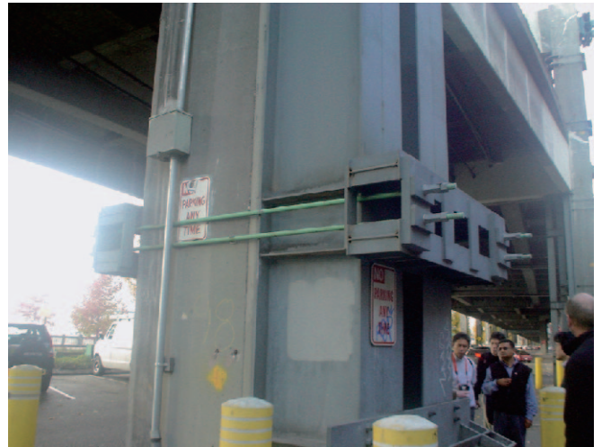
写真-4 地震被害復旧後の高架橋コンクリート橋脚 (Alaskan Viaduct)
