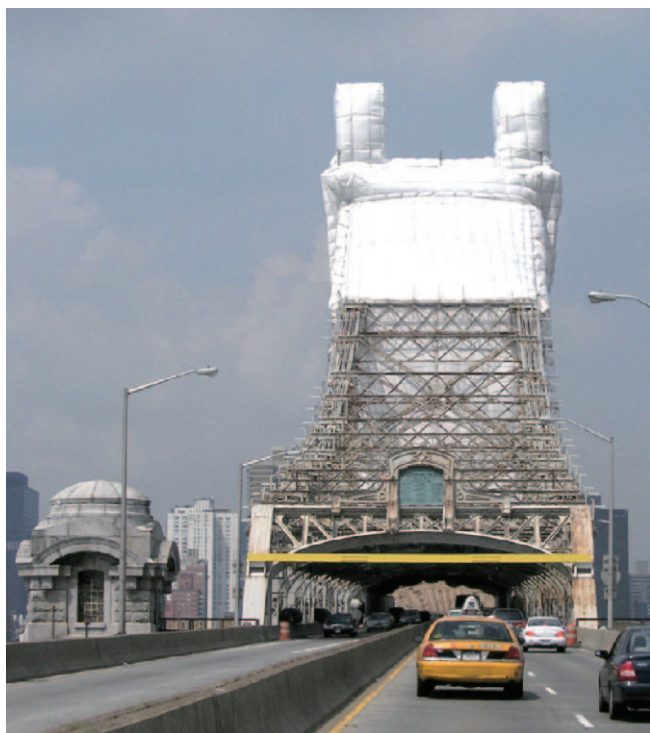
写真－1 クイーンズボロー橋の再塗装(飛散防止対策を行っている)
