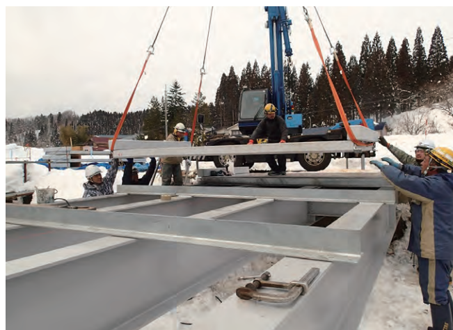
写真-7 CLT床版の架設
