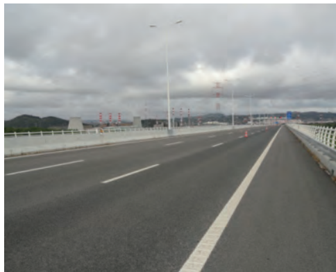
写真-3 照明柱を中央分離帯側に設けた事例
