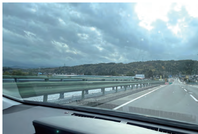
写真-10 ガードレール防護柵
