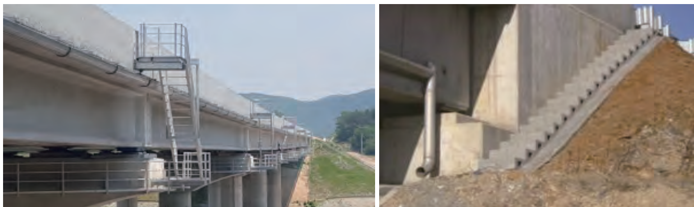
写真-5 橋梁側面、橋台に設けた階段式昇降設備
