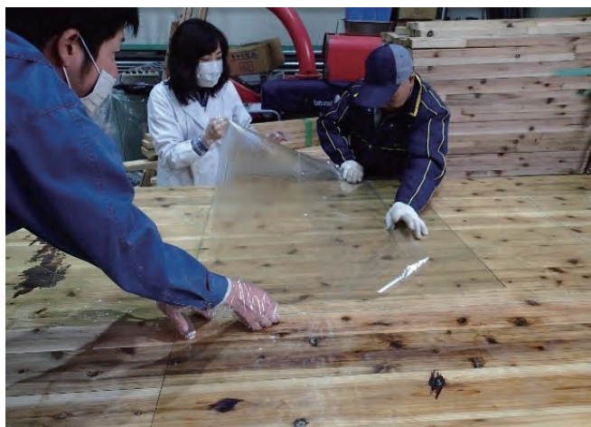
写真-4 FRPシートによるラッピング
