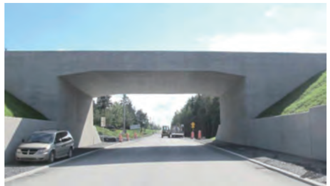
写真-1 インテグラルブリッジの事例
