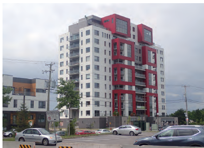
写真-2 CLT建築（カナダ・ケベックシティ）
