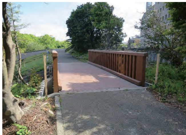
写真-9 歩道橋のCLT床版（鹿児島市）
