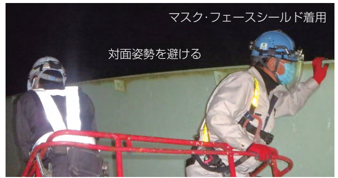
図-2 高所作業車での作業状況
