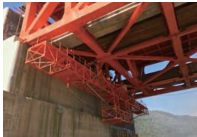
写真-4 移動足場へのアクセス事例
