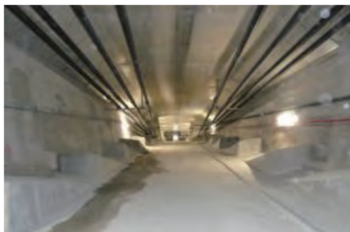
写真-6 桁内照明の事例
