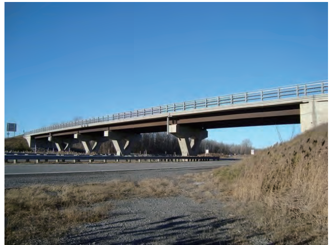
写真-7 高速道路40号線を跨ぐ合成床版橋
