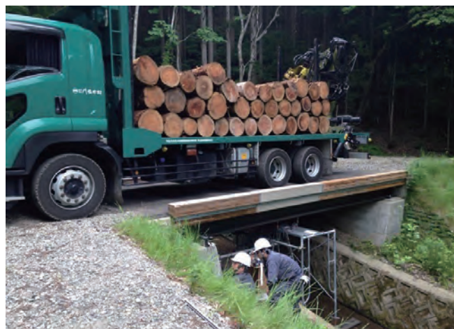
写真-5 CLTを用いた林道橋（秋田県仙北市）
