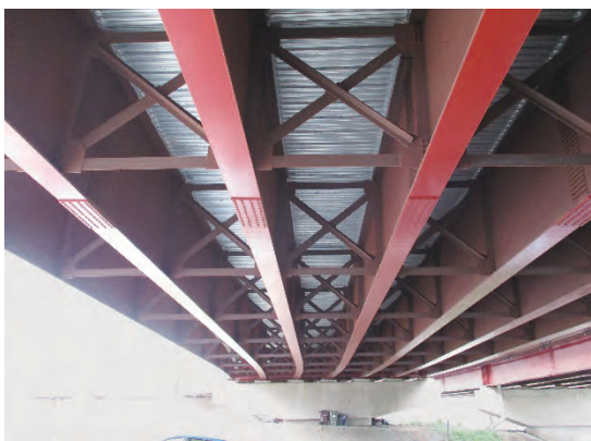
写真-13 跨道部下面状況
