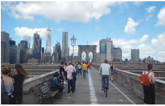
写真-15 上層の歩道からの橋梁全景
