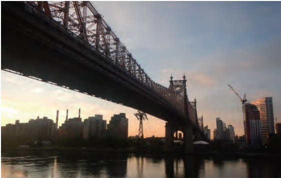
写真-17 橋梁全景
