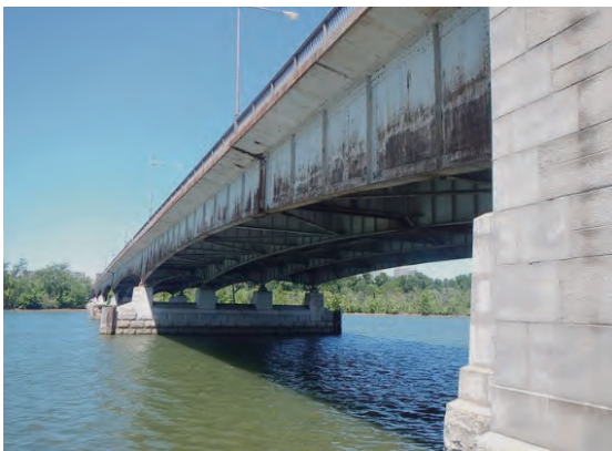
写真-9 橋梁全景
