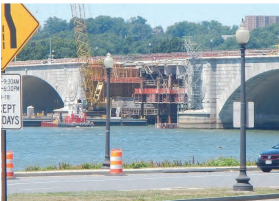
写真-11 センタースパンの工事の状況
