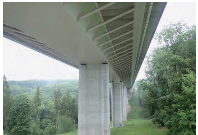
写真-4 フラビンカ高架橋
