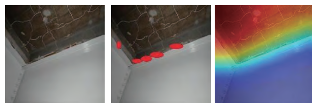
(c) 点検損傷度 (c) ⇔ CNN 損傷度 II (TN)
