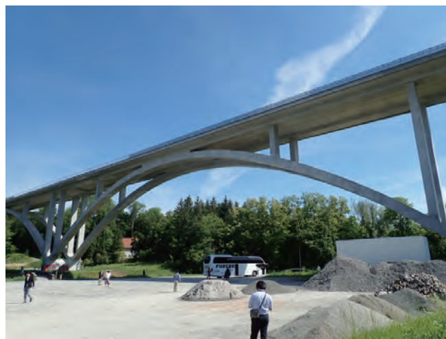
写真-12 ムルバレー高架橋
