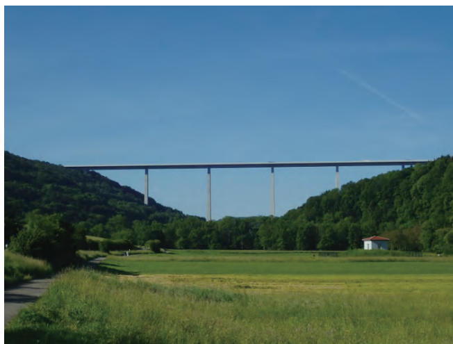
写真-11 コッターール高架橋
