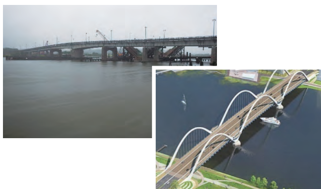
写真-5 橋梁全景 (架け替え工事中) と将来完成予想図
