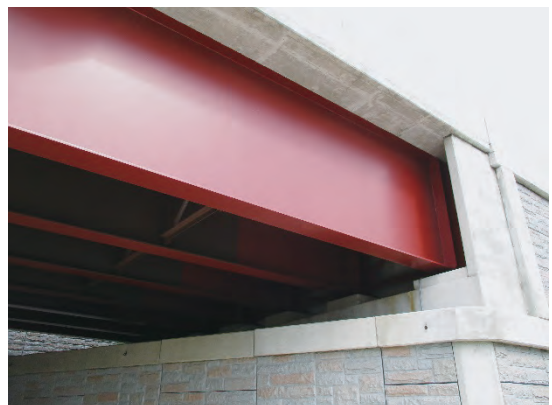
写真-14 端支点部
