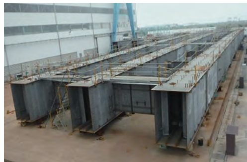
写真-2.15 狭小箱桁橋
