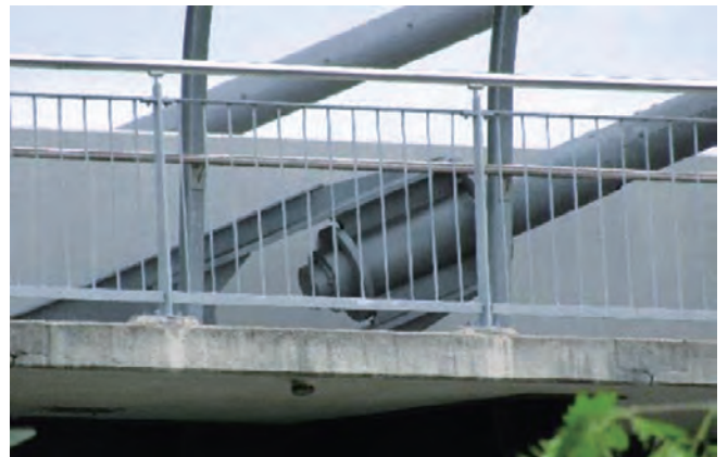
写真-8 斜材ケーブル定着部
