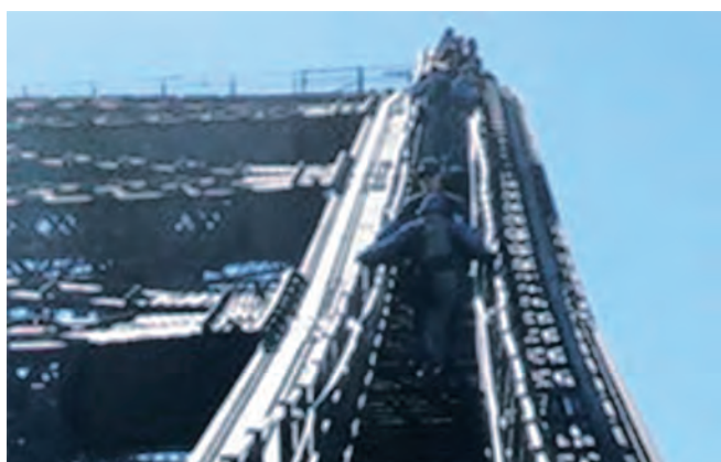
写真-5 アーチ頂部近接状況
