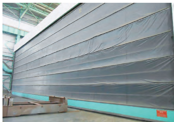
写真-2.8 プラスト養生状況写真
