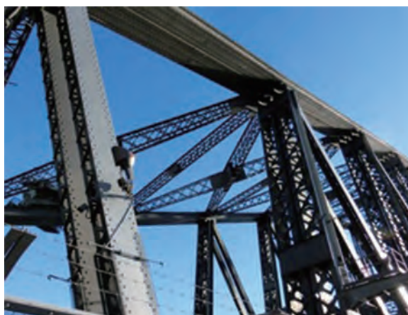
写真-7 アーチ部材の状況
