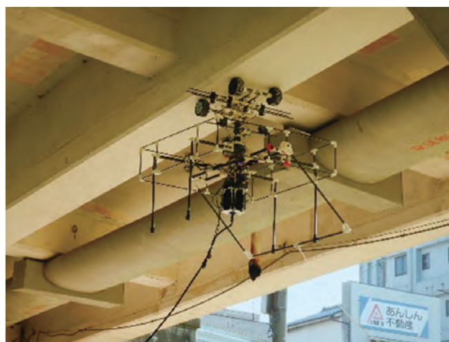
写真-3.6 打音検査状況
