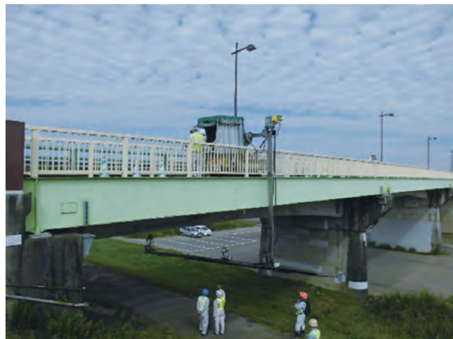
写真-3.5 実橋でのうき・はく離の検証
