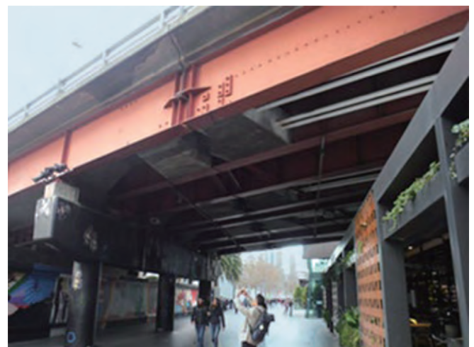
写真-11 キングストリートブリッジの桁下
