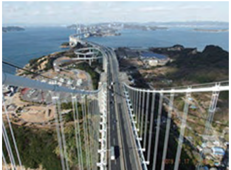
写真-3 大規模橋梁の例 (本四架橋)
