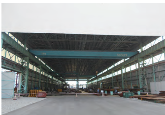
写真-2.9 製作工場
