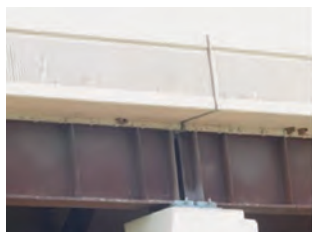
写真-2 耐候性橋梁（自動車専用道）
