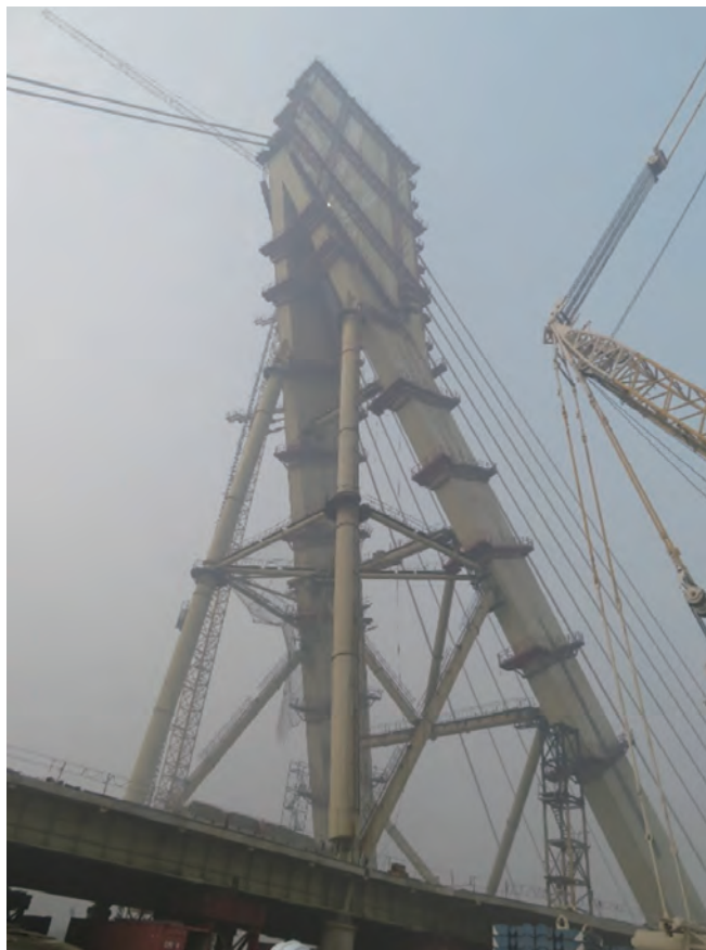
工事中の主塔全景
