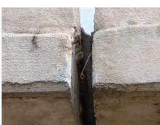
写真-5 一般道（伸縮装置ゴム止水材端部の曲上部）
