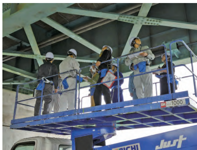
写真-2 研修会（現地実習）の状況
