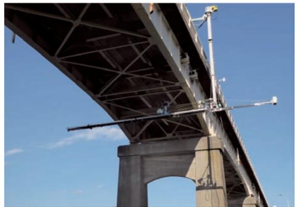
写真-3 幸久橋鋼桁部を点検する車両型（アーム型）ロボット
