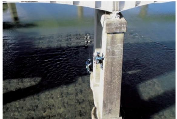
写真-4 従来方式による損傷箇所を検出（川中の橋脚、ロープアクセス）
