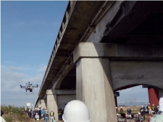
写真-2 幸久橋コンクリート桁部を点検する飛行型ロボット
