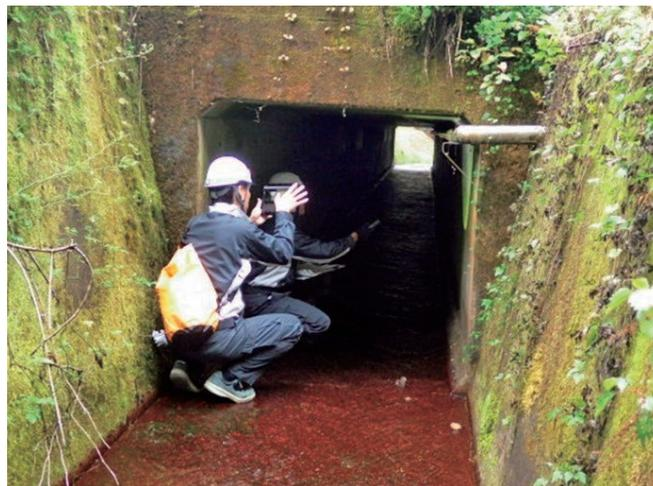
写真-4 タブレット点検（小規模橋梁に活用）
