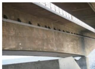
写真-11 主桁の表面劣化
