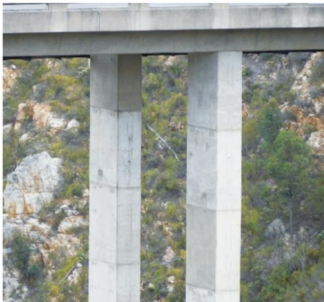
写真-2.5 鉛直材上端 (剛結部)
