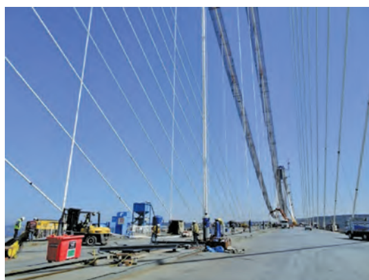
写真-2 吊橋と斜張橋併用区間
