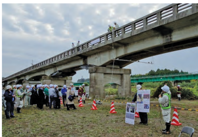
写真-6 桁下を移動中の懸架型（幸久橋）
