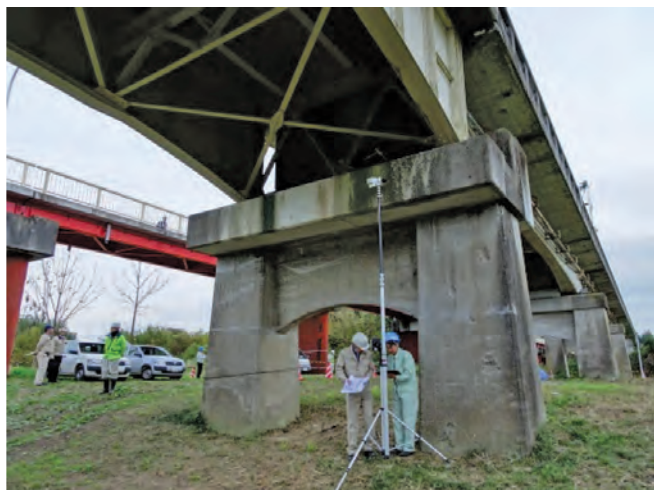
写真-5 点検中のポール型（地上設置式）（幸久橋）
