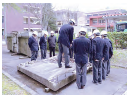
3 限目 コンクリート損傷部材見学・解説
