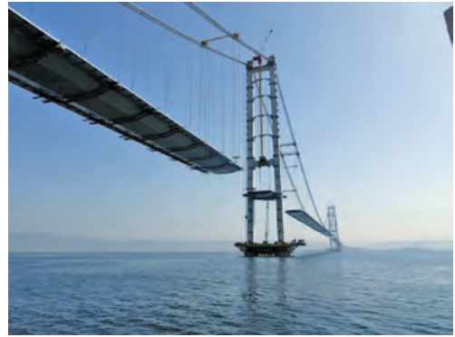
写真-5 橋梁全景
