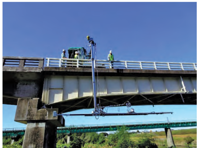
写真-3 路面上のクローラ式車両から点検アームを操作(幸久橋)
