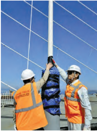
写真-4 ケーブルの振動を確認
