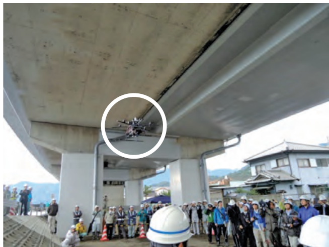
写真-1 桁下に近接して撮影するドローン(蒲原高架橋)
