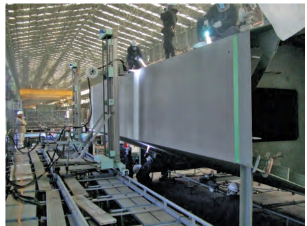
写真-6 金属溶射状況
