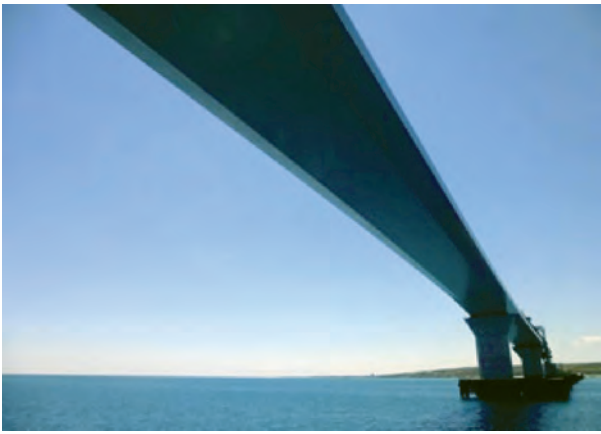
写真一七 主航路部設置状況
