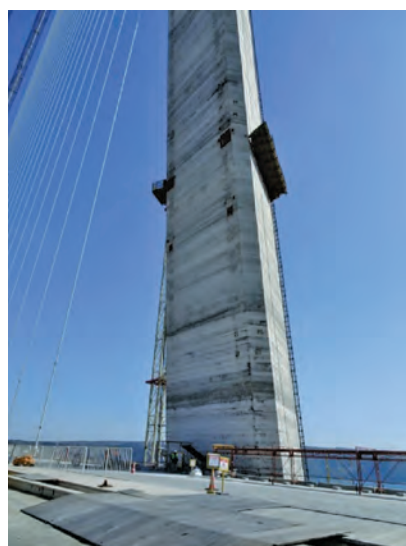
写真-3 コンクリート製主塔
