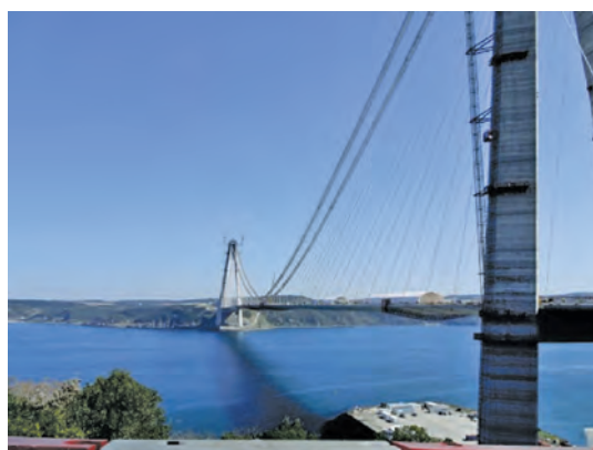
写真-1 橋梁全景
