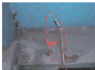
写真-2 支承の機能障害より発生した亀裂 2)
