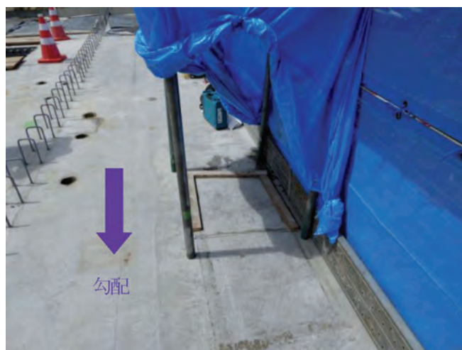
図-12 測定箇所に設けた小屋の様子
