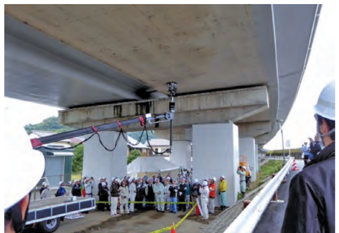
写真-4 トラックから伸ばしたアームによる打音調査(蒲原高架橋)
