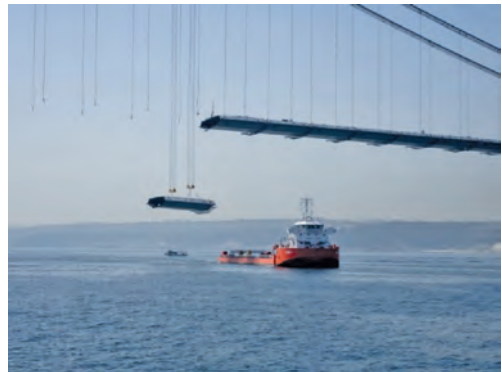
写真-6 桁のブロック架設
