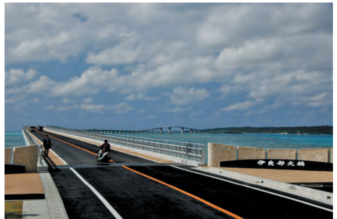
写真-4 伊良部大橋 2015（平成27）年1月供用開始
