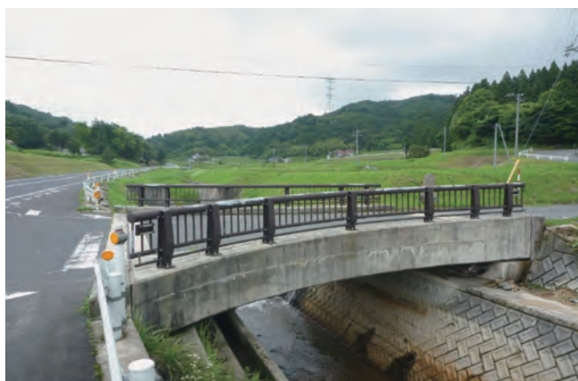
扇橋 (橋長8.6m幅員9.3m)
