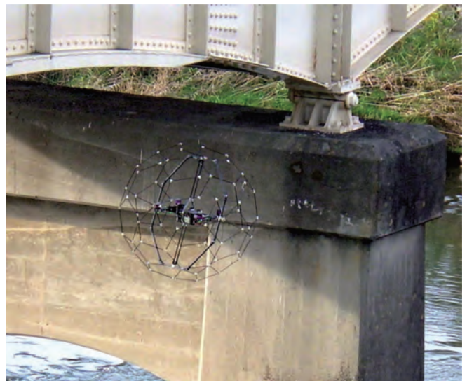
写真-2 支承回りを飛行するドローン(球殻式)(幸久橋)
