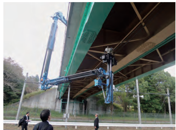
写真-5 車両系点検装置の点検状況 (国総研内橋梁)
