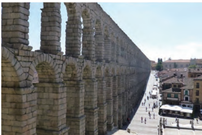
写真-6 ローマ水道橋 その2
