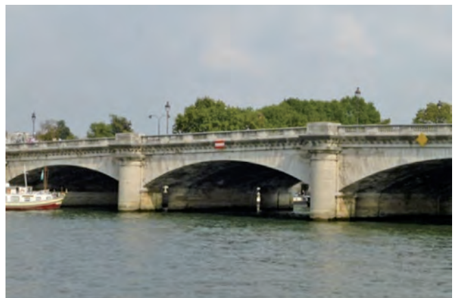
写真-8 コンコルド橋
