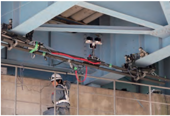
写真-6 懸架系点検ロボットの走行設備取付け作業 (新浅川橋)
