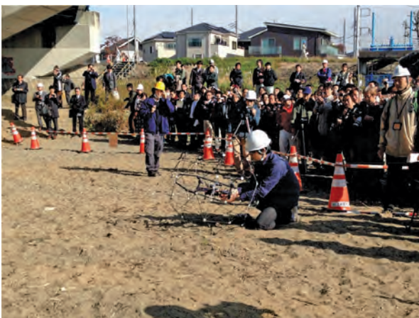
写真-3 飛行系 (球殻で覆われたドローン型) 点検ロボットの飛行準備 (新浅川橋)
