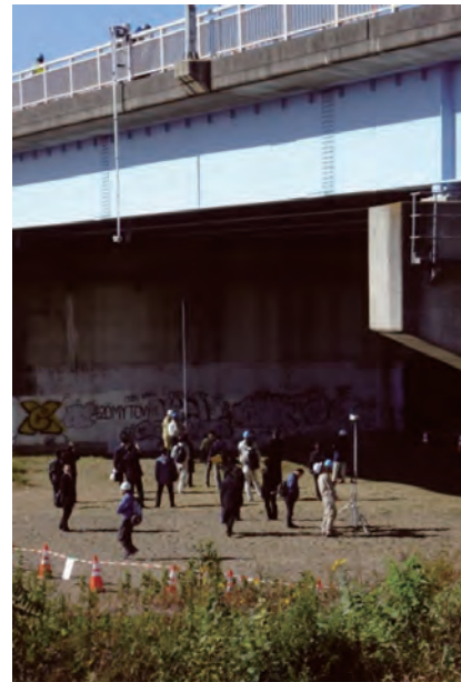
写真-7 ポール系点検装置の点検状況。地上と橋上の両方から点検。(新浅川橋)
