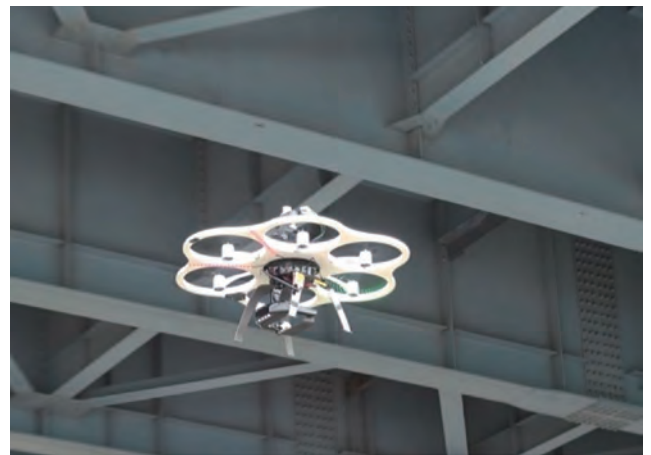
写真-1 飛行系（ドローン型）点検ロボットによる鋼桁点検（新浅川橋）
