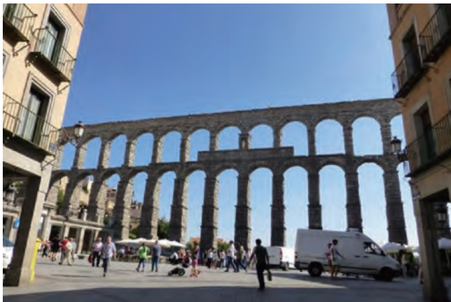
写真-5 ローマ水道橋 その1
