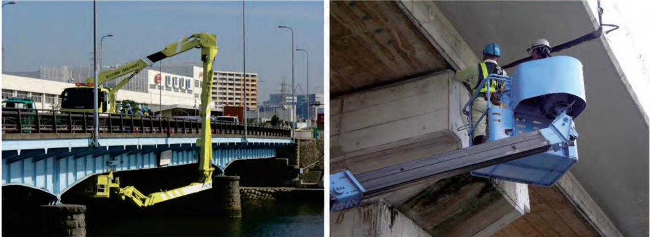
写真－1 近接目視による現地診断状況
