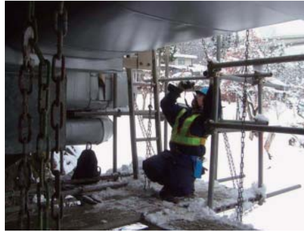
足場上での検査（東北支部）
