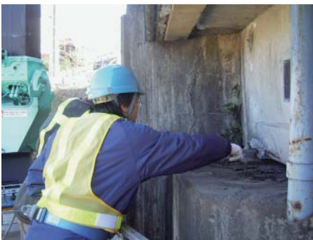
橋台支承部の検査（中部支部）
