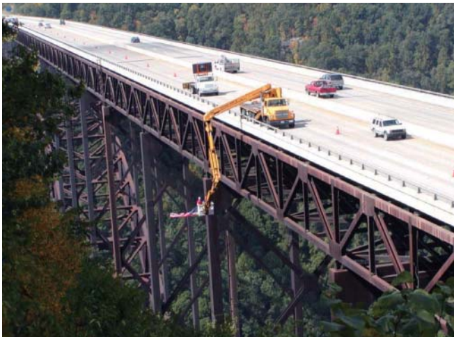
テレスコーピックアーム作業車による橋梁検査
