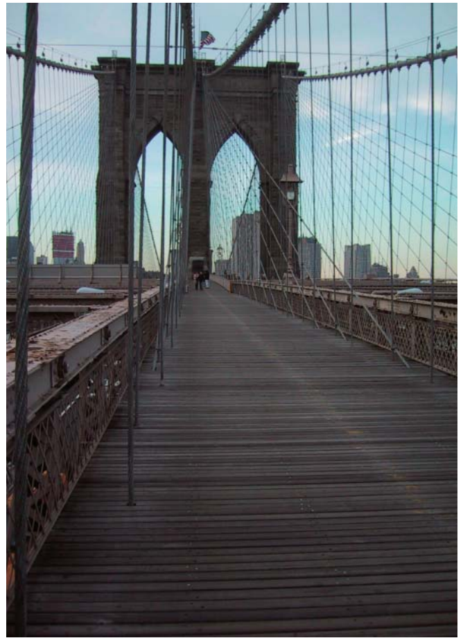
図-6 ブルックリン橋。タワースティケーブルの破断事故時点で、完成後98年が経過していた。
