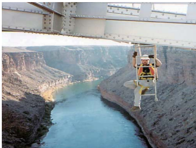
簡易ゴンドラによる橋梁検査
