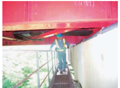
橋脚の検査（北陸支部）
