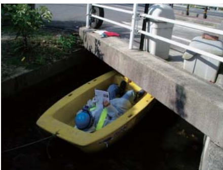
小船を使った橋梁裏面の検査（中国支部）
