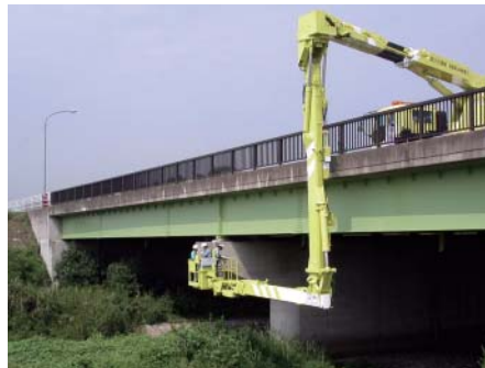
橋梁点検車をを使った検査（関東支部）
