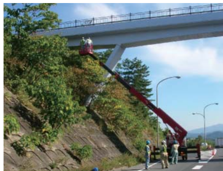
高所作業車を使った検査（近畿支部）
