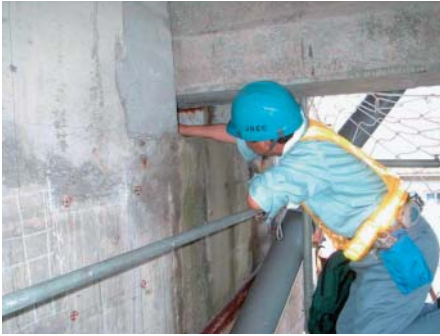
橋台支承部の検査（東北支部）
