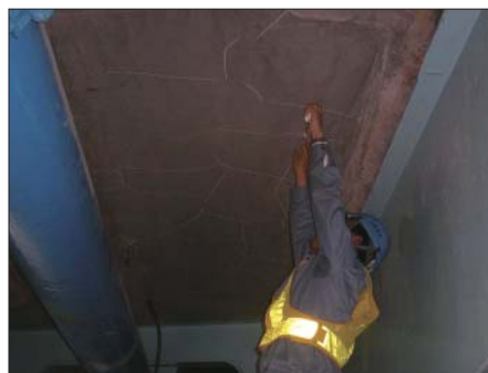
床版裏面の検査（四国支部）
