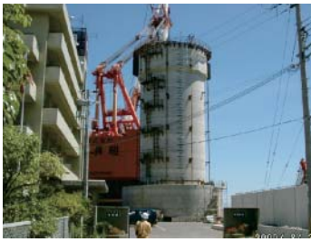
陸上ヤードでの構築
