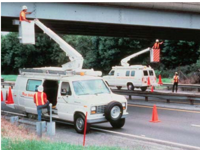
移動作業車による検査
