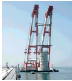
大型クレーン船による吊り曳航
