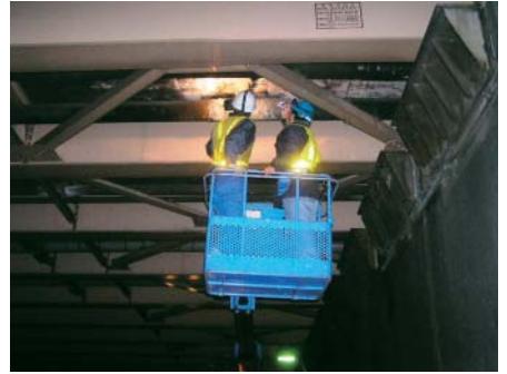
橋梁点検作業車を使った検査（関東支部）
