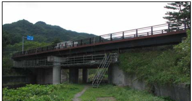
撮影年月日：2006年9月22日（橋梁管理カルテ）
