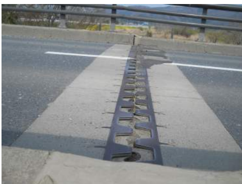
第 7 径間 P7 側ゲルバー部（本線橋）
