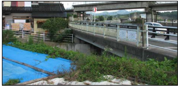
撮影年月日：2010年10月1日（橋梁管理カルテ）
