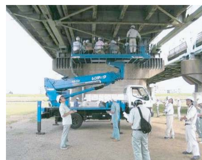
道路橋点検士技術研修会 （現地実習）
