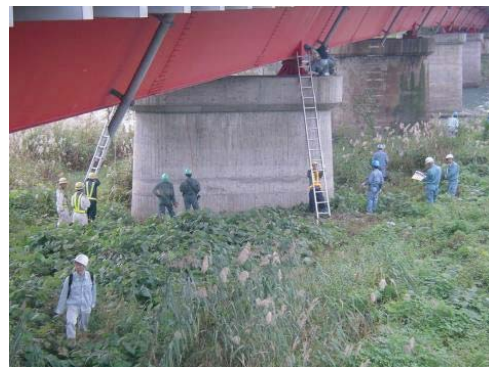
震災により損傷した橋梁の詳細調査
